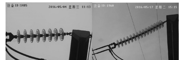
图25 玻璃绝缘子自爆
